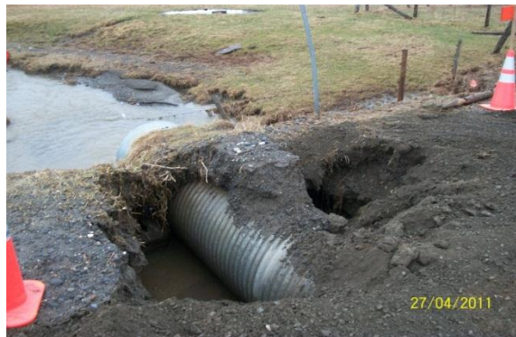
Ponceau du chemin Mailloux
